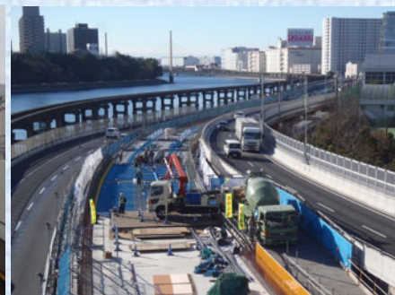
床版打設状況
