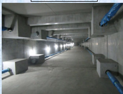
函体内部の状況
