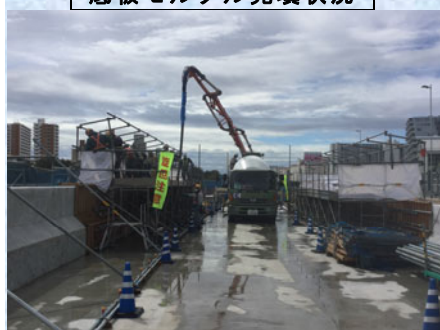
地覆・壁高欄打設状況
