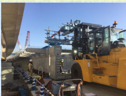
セグメント架設
