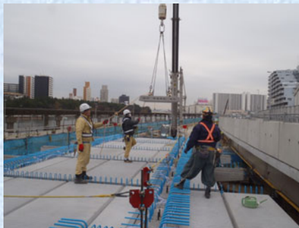
P C 板敷設状況
