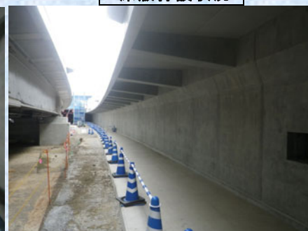
函体外部の状況
