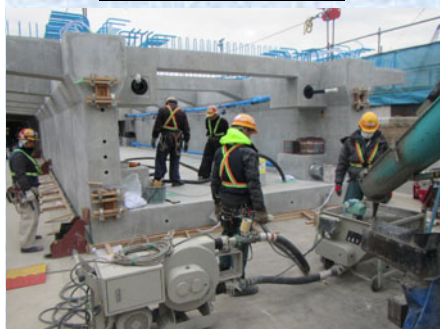
底板モルタル充填状況
