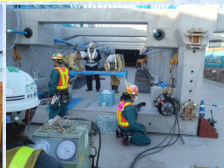
ケーブル緊張状況
