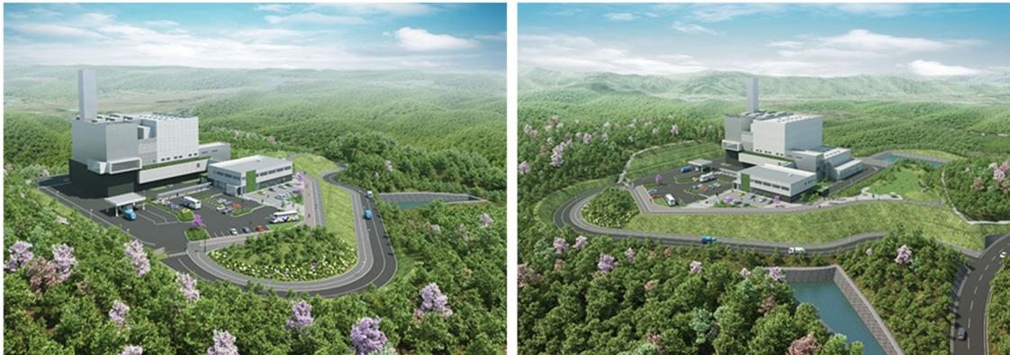
埼玉県鶴ヶ島市、毛呂山町、鳩山町及び越生町の1市3町から、排出される可燃性のごみを安定的かつ安全に焼却処理する施設を鳩山町内に建設し、完成後15年6か月にわたって、施設を運営管理するDBO（Design Build Operate）方式が採用されています。また、可燃ごみを焼却処理する過程から得られる熱を利用し、発電等、地球環境に配慮した効率的なエネルギー回収も行う計画です。このような環境への配慮や保全管理業務に関する定期点検方法などの具体的な提案を評価いただき、受注に至りました。
