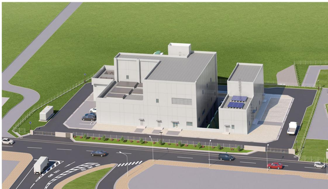
宇部市の公共下水道は事業着手から70年近く経過しており、施設や管渠（排水路）の老朽化が進んでいます。本事業は、既設の栄川ポンプ場（1957年供用開始）と鶴の島ポンプ場（1967年供用開始）の老朽化にともない両ポンプ場を廃止し、それらの機能を統合して新たに玉川ポンプ場を整備するものです。
