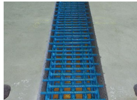
床版継手部の配筋状況
