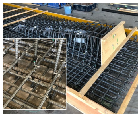
Trunc-headによる配筋
