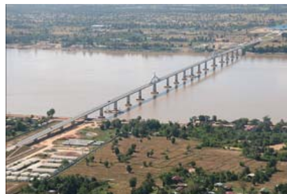
第2メコン国際橋
