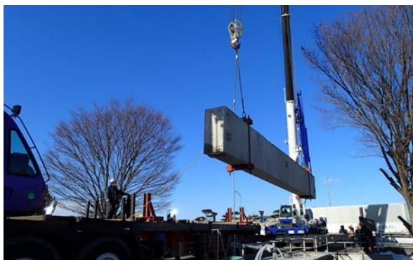
【PC橋主桁の撤去作業】
