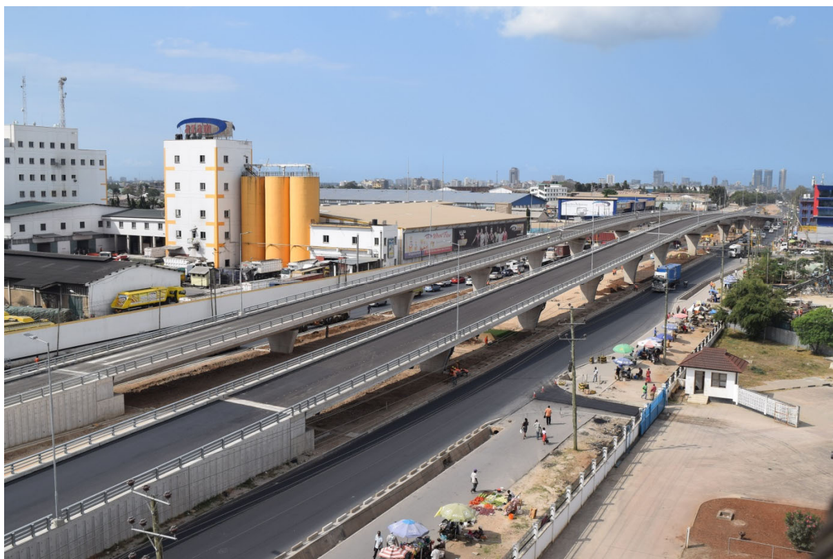
竣工した ムフガレ・フライオーバー
