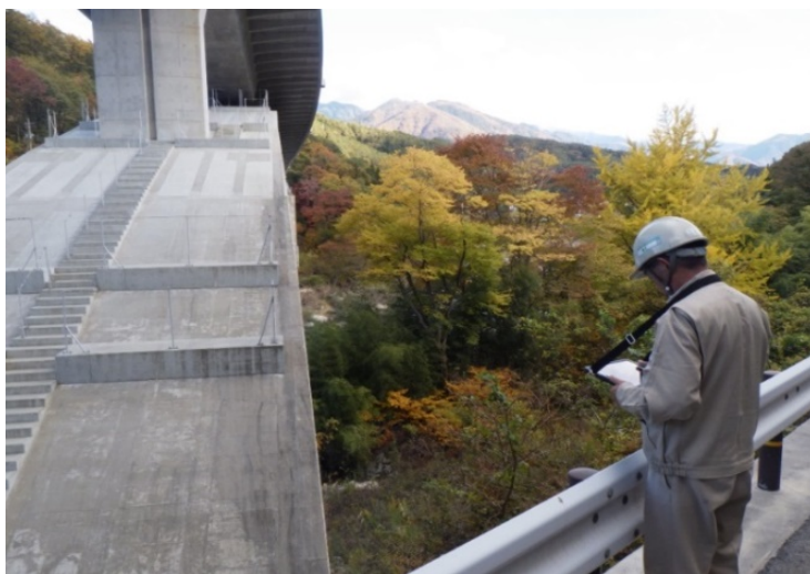
【「Maplet SM」を用いた橋梁点検作業の様子】
