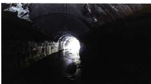
【照明設備がない暗渠内】
