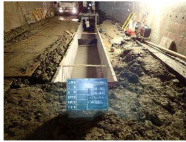
(U型土留め設置)
