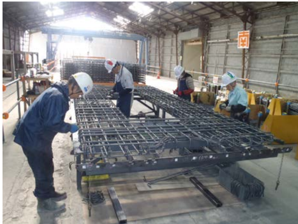
【作業員による鉄筋組立作業】
