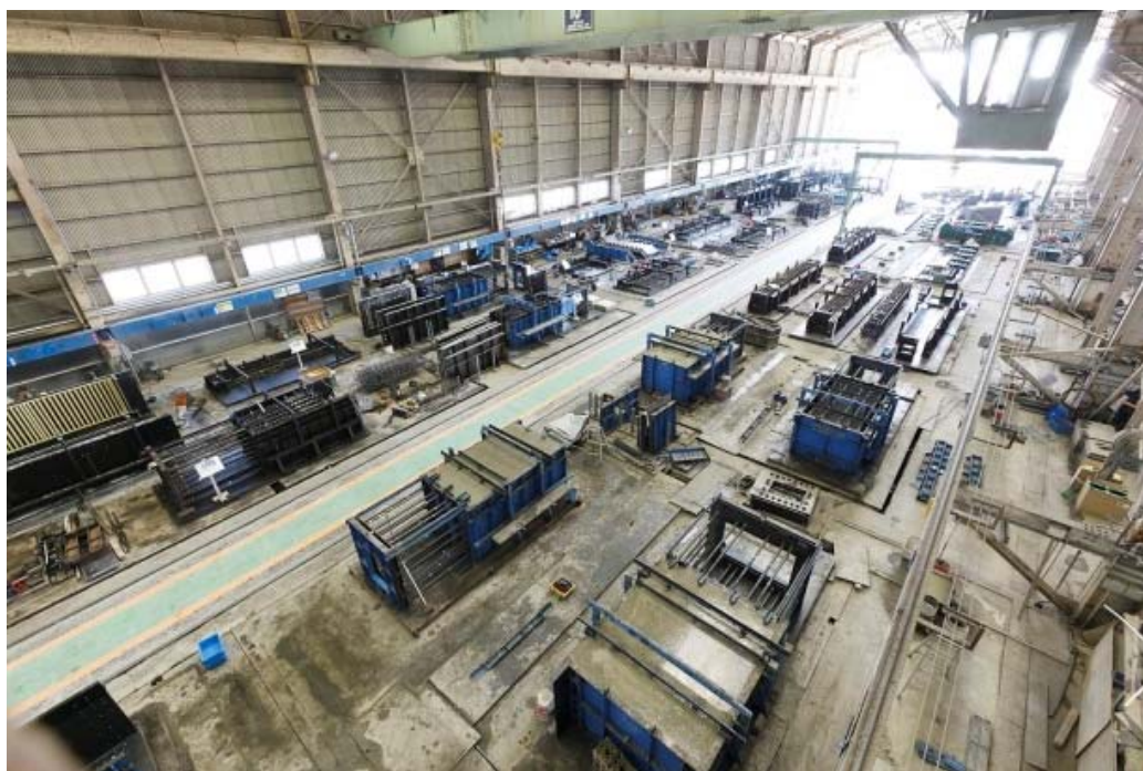
【PCa 工場の製造ライン全景】
