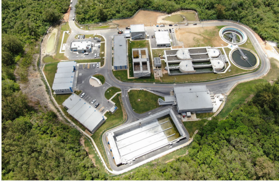
【竣工した下水処理場】
