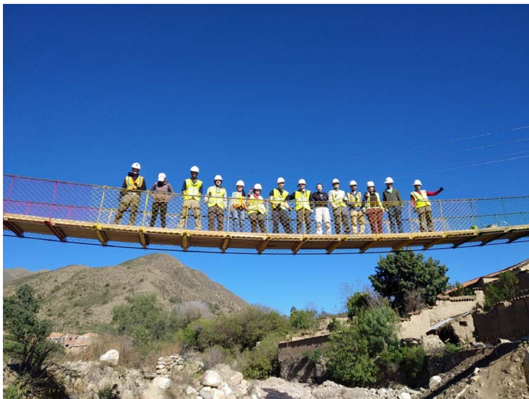
【完成した人道橋とプロジェクトメンバー】
