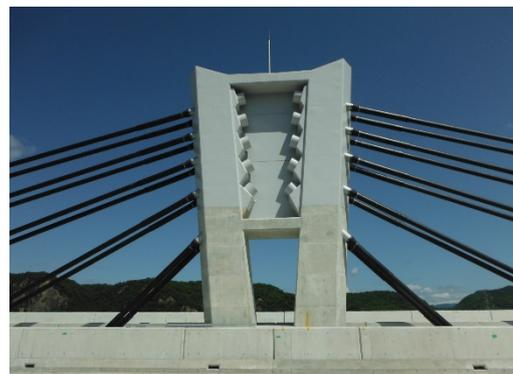
図-5 鋼板とコンクリートを組合せた主塔構造
