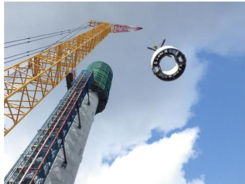
図-3 ハーフプレキャストによる橋脚の構築
