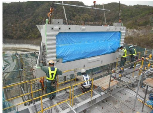
図-4 プレキャスト部材による橋脚の頭部付近の構築
