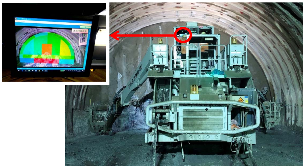
【ドリルジャンボと適正火薬量がリアルタイム表示された搭載モニタ】
