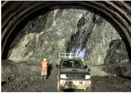
【3D レーザースキャナによる切羽計測】
