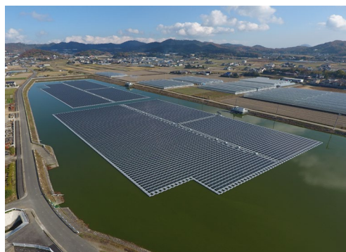
【女井間池水上太陽光発電所】
