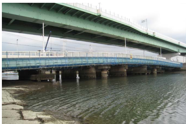
【橋脚の耐震補強工事が進む開橋】
