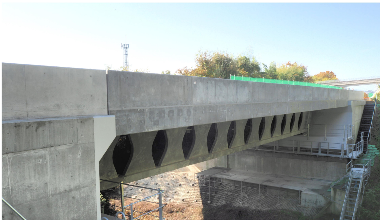
図-1 別埜 べっそだにばし 谷橋の完成状況
