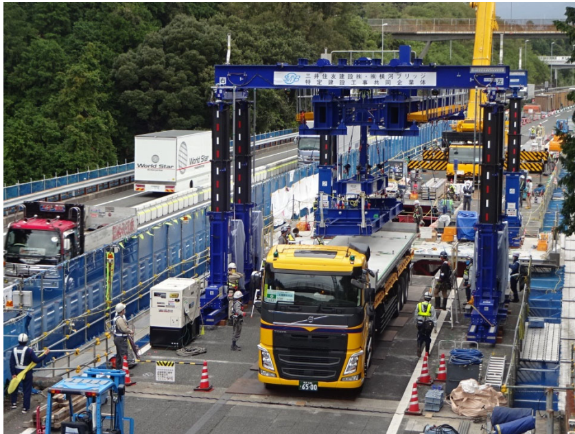
【裾野 IC～沼津 IC 間床版取替工事の様子】
