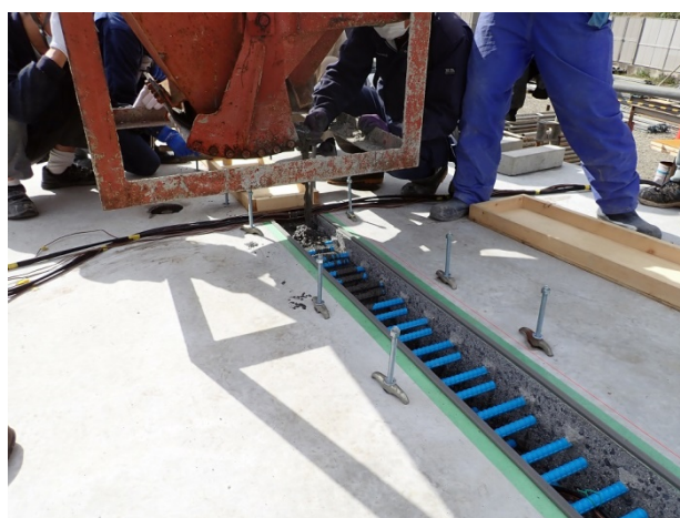
【超高強度繊維補強サスティンクリートの製造と打込み作業の様子】
