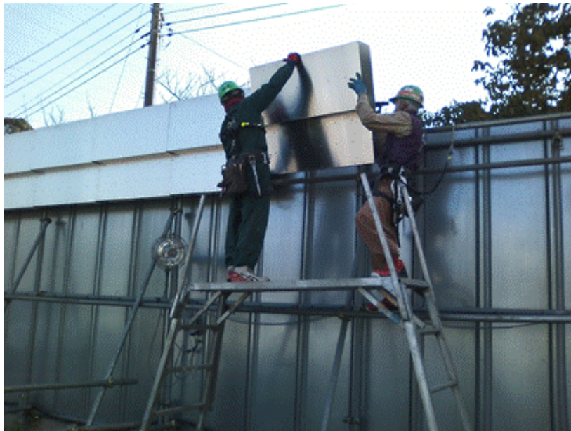
【改良した「レゾクラウンサイレンサー ® 」設置作業の様子】
