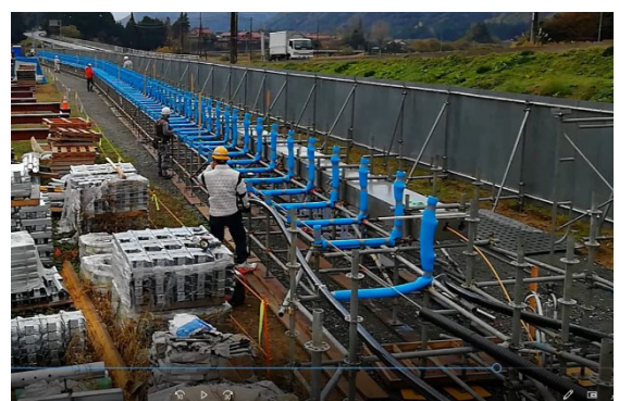
写真-4 要素試験(緊張材の施工性)
