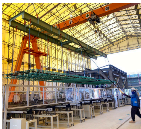
【鉄筋組立完了した PC 床版】
