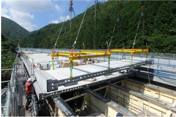
写真-1 Dura-Slab 架設状況
