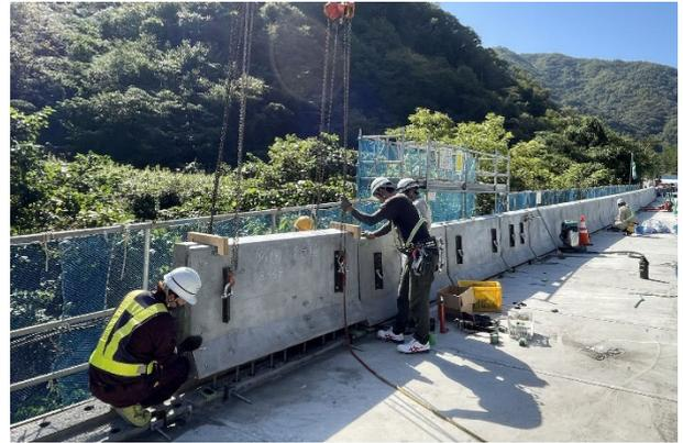
写真-2 Dura-Barrier 架設状況
