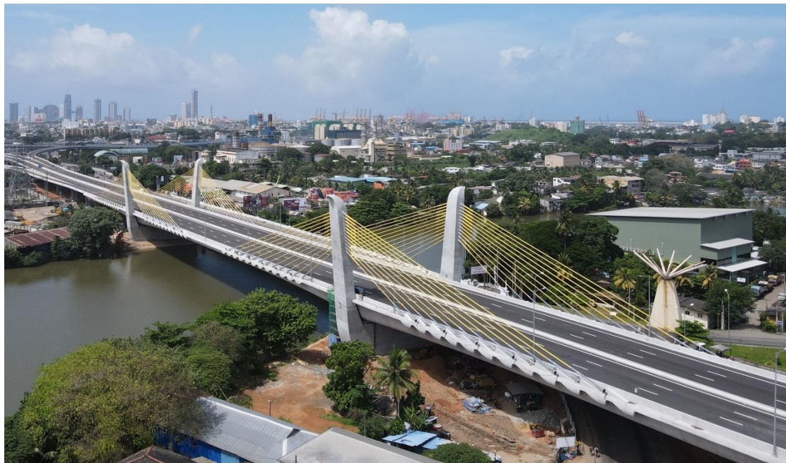
【完成したケラニ河新橋建設事業（パッケージ2）】
