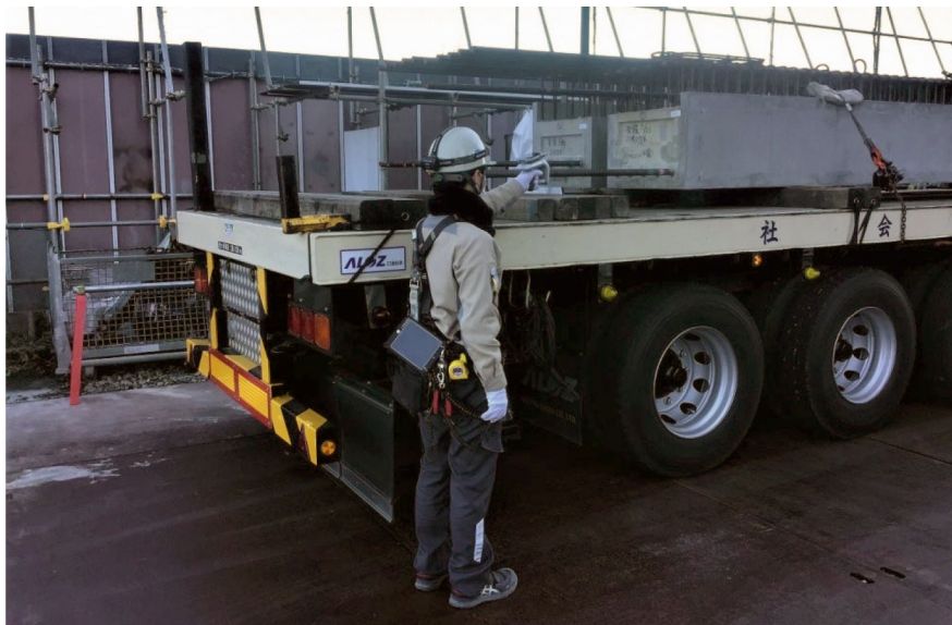
【現場納入時に RFID タグを読み取る様子】
