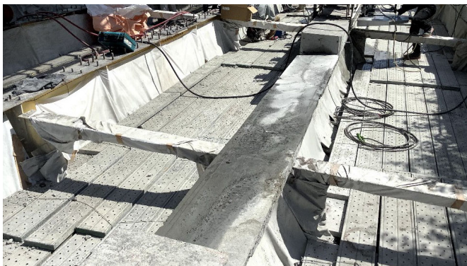
【接合部の床版撤去後の切断面】
