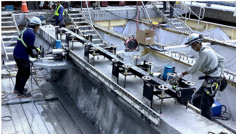
【床版切断システム「水平カッター」による撤去作業の様子】
