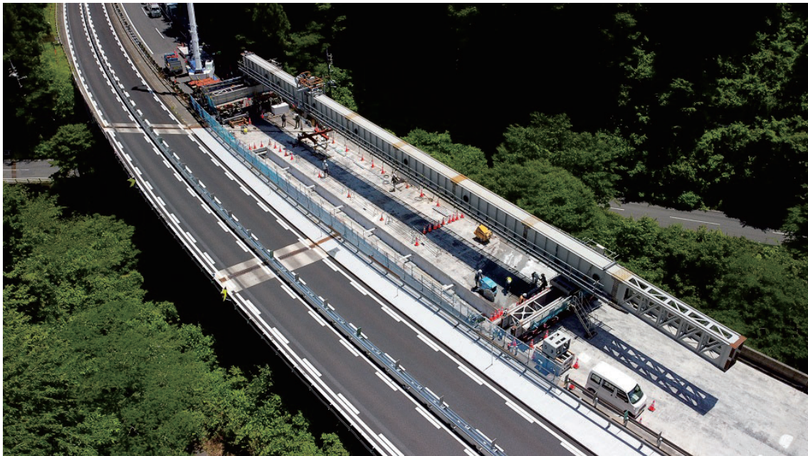
【架設機を用いた床版取替作業の様子】
