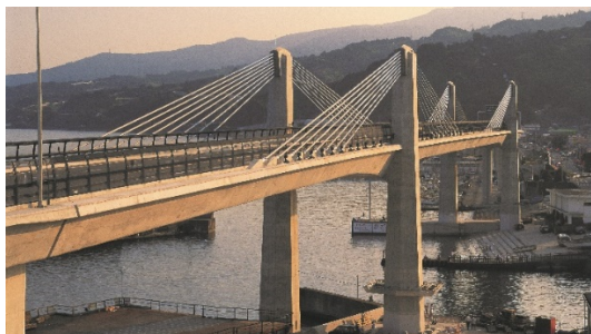
小田原ブルーウェイブリッジ (世界初のエクストラードーズド橋) 所在地：神奈川県 竣工：1994 年
