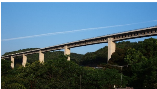
寺迫ちょうちょ大橋 (世界初のバタフライウェブ橋) 所在地：宮崎県 竣工：2013 年
