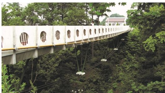
青春橋 (世界初の二重張弦桁構造) 所在地：群馬県 竣工：2006 年
