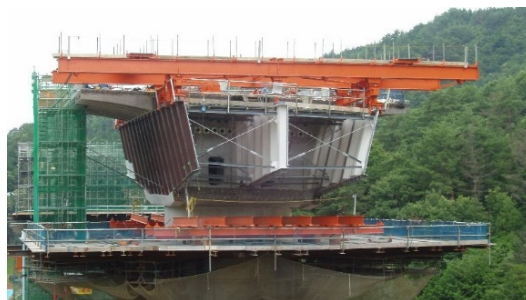
信楽七号橋 (世界初の Rap-Con 工法 (複数ブロック同時施工)) 所在地：滋賀県 竣工：2004 年
