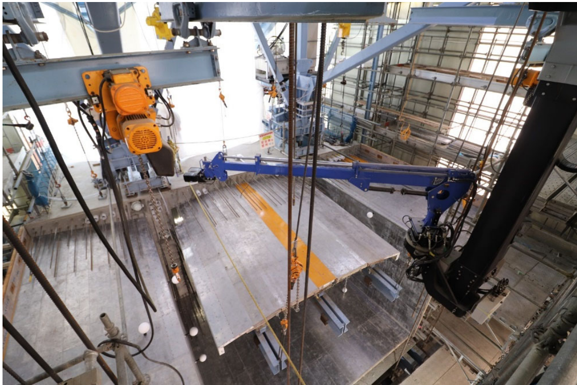
【完全自動化した「SMC-スマートメジャー ® 」による検測作業の様子】
