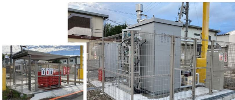
【今回導入した水素蒸気ボイラー (左：水素貯蔵設備)】
