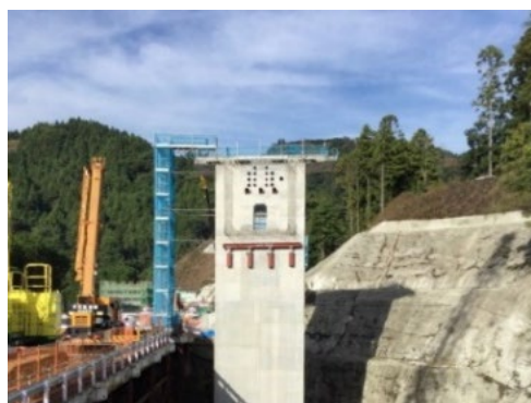
【柱頭部横桁の構築】
