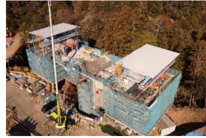
【片持ち架設状況】
