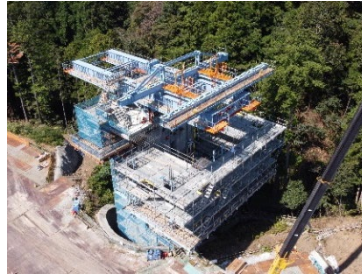
【ガーダー式コンパクトワーゲン組立状況】
