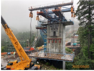
【ガーダー式コンパクトワーゲン組立状況】
