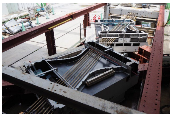
【アラミドFRP ロッドを用いた部材製造と施工中の様子】
