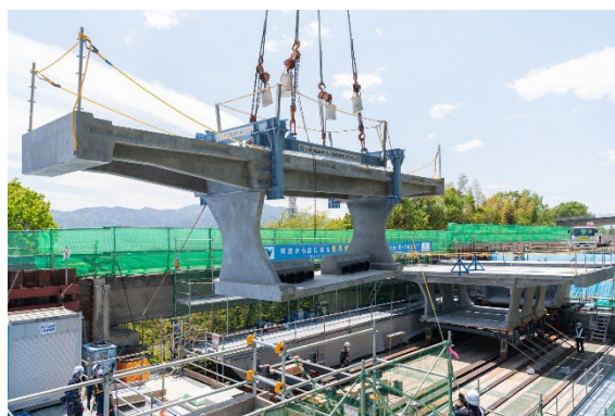
【アラミドFRP ロッドを用いた部材製造と施工中の様子】
