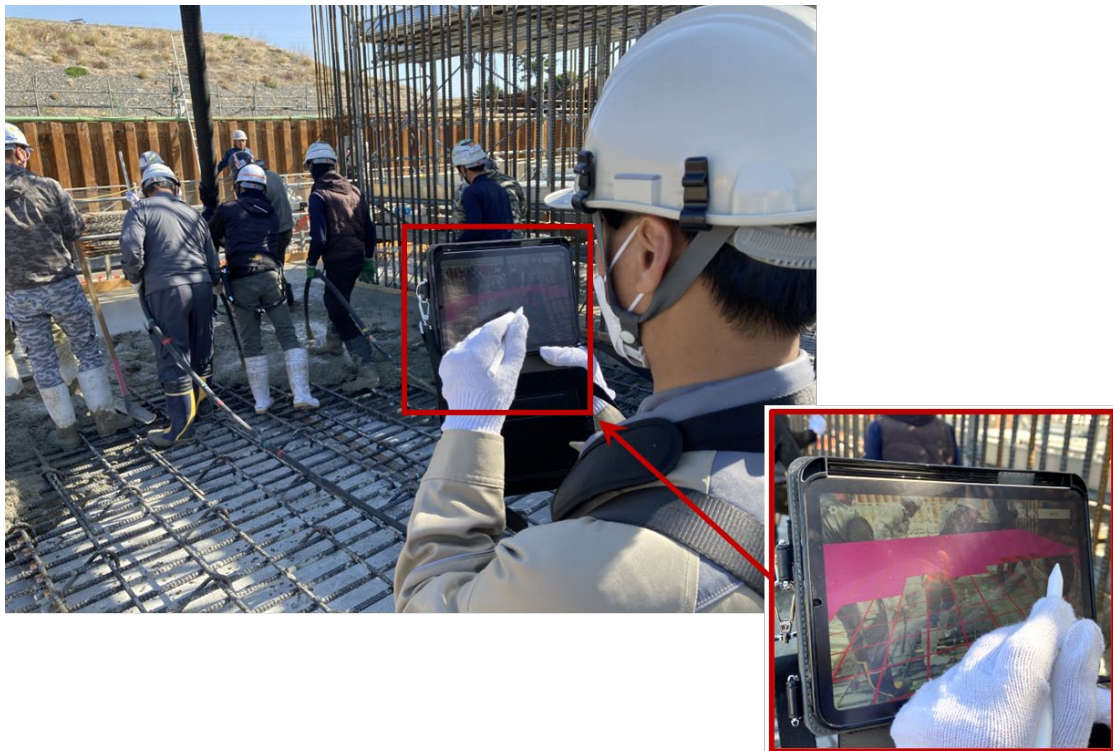
【「AR コンクリート締固め管理システム」を用いた作業の様子】
