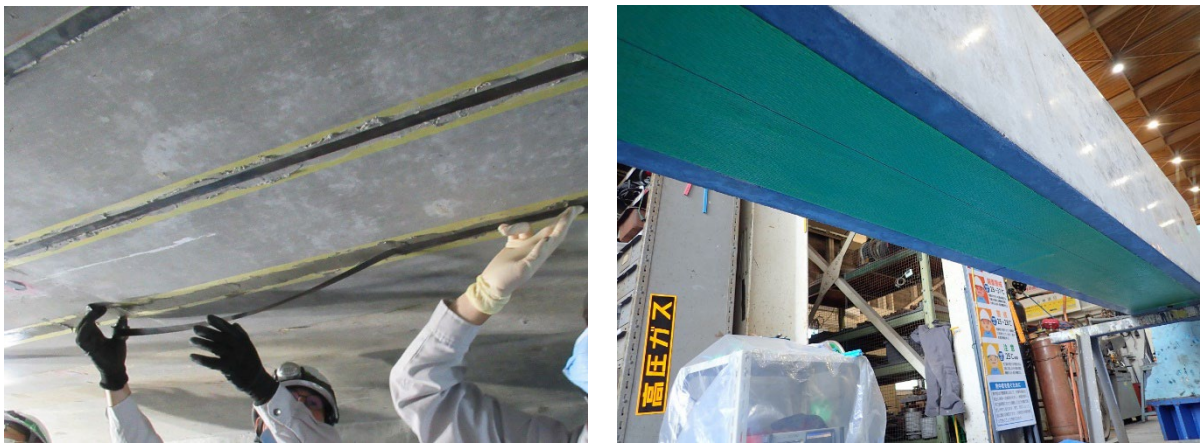
【テープ式陽極材の貼り付け状況（左）とテープ式陽極材の上に貼り付けたアラミド連続繊維シート（右）】
