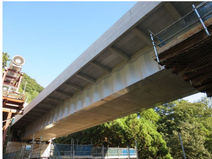
【「Rap-con for staging 工法」を初適用した新東名高速道路皆瀬川橋（仮称）】
