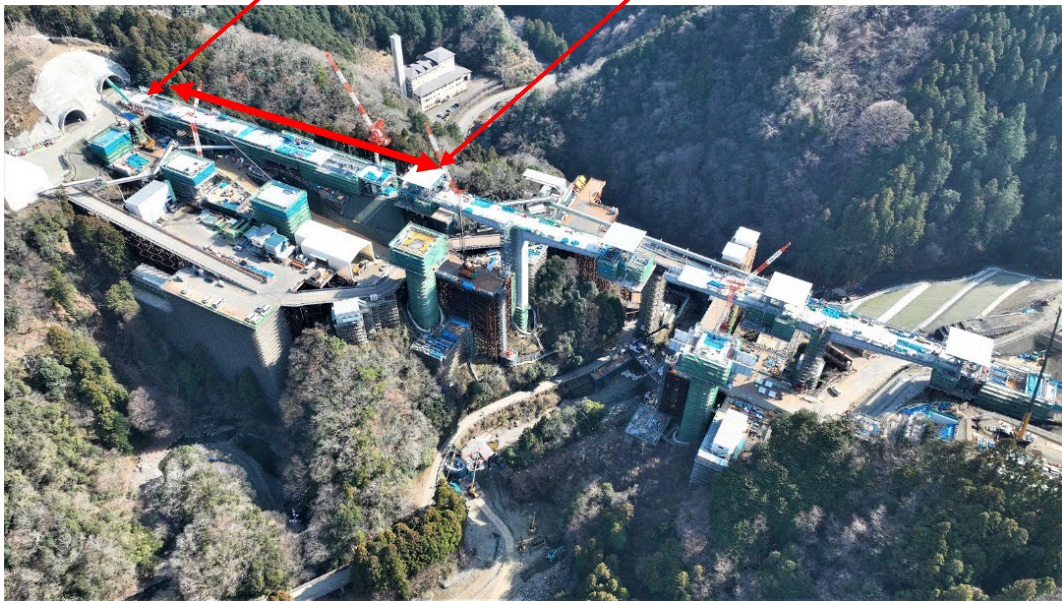
【現場の全景と「Rap-con for staging 工法」が初適用された工区】
