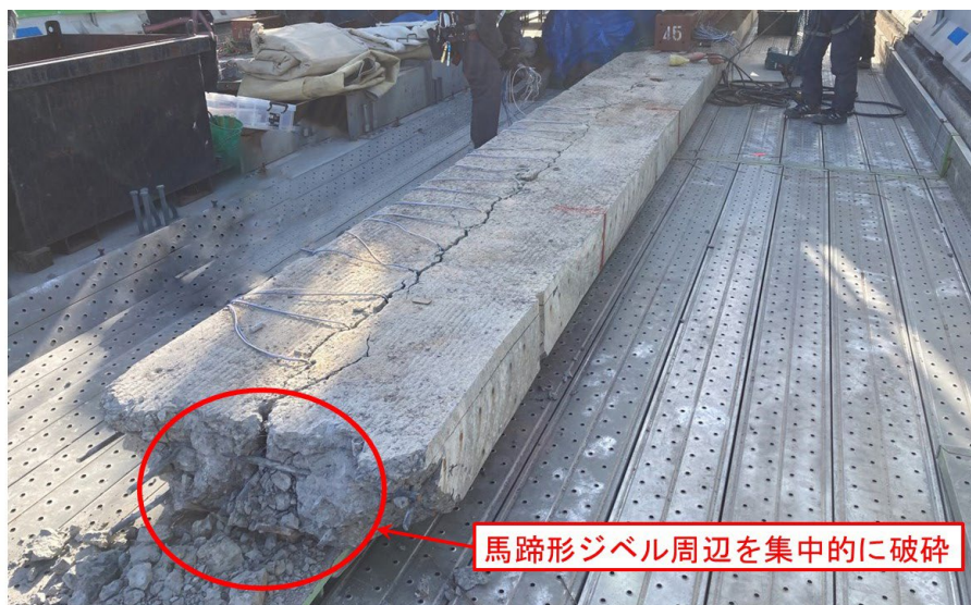
【「SMartD」によるコンクリートの破砕状況】
