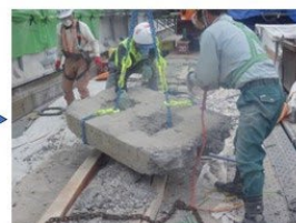
(床版分離・解体)
