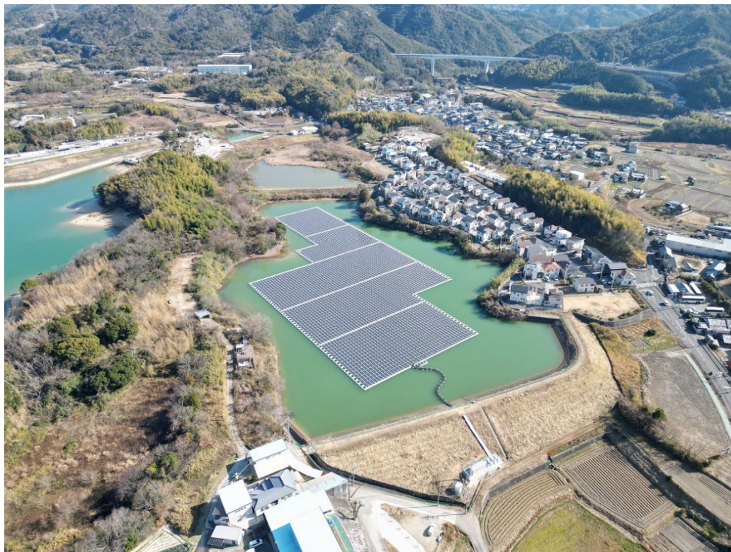
【売電事業を開始した「泉佐野市郷之池水上太陽光発電所」】
