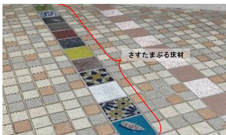
【床材の施工状況】
