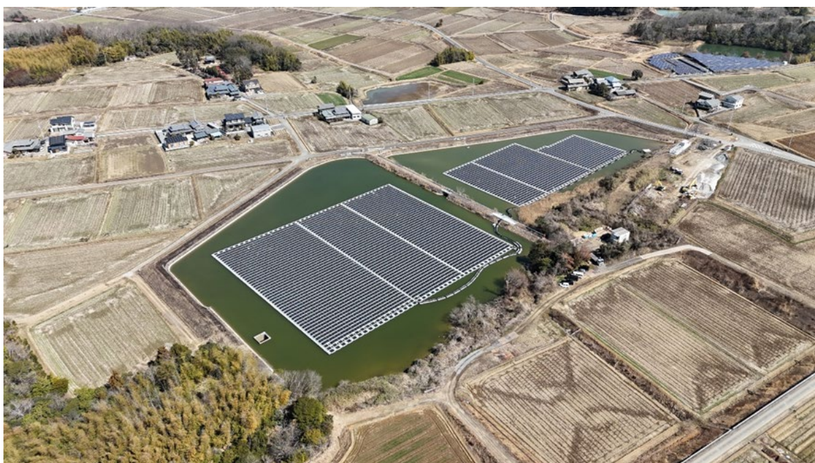
【完成した「加東市（平池・新池）水上太陽光発電所」】
