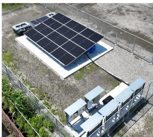
【比較のために設置した陸上部の太陽光パネル】 (パワーコンディショナーと蓄電池を併設)
