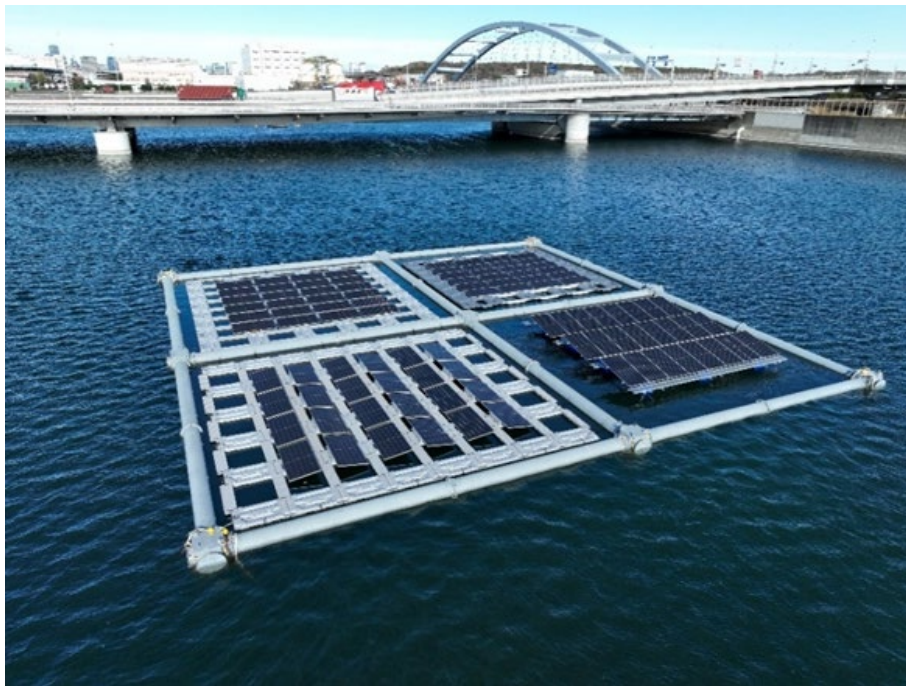
【洋上浮体式太陽光発電施設（2025 年 3 月末撤去済み）】
