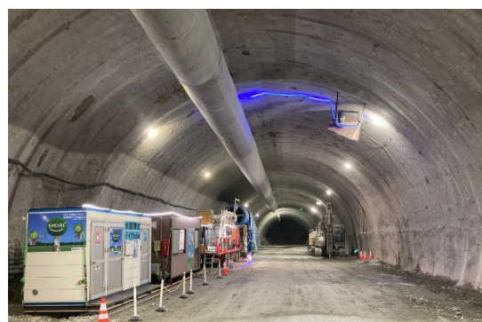
【稼働状況（山口県：トンネル建設現場内）】
