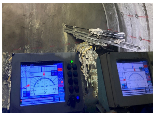
ドリルジャンボ穿孔誘導システムとの連携による穿孔作業
