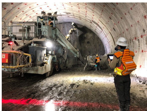
「AI de 先ヤマ(発破編)」現場実証状況
