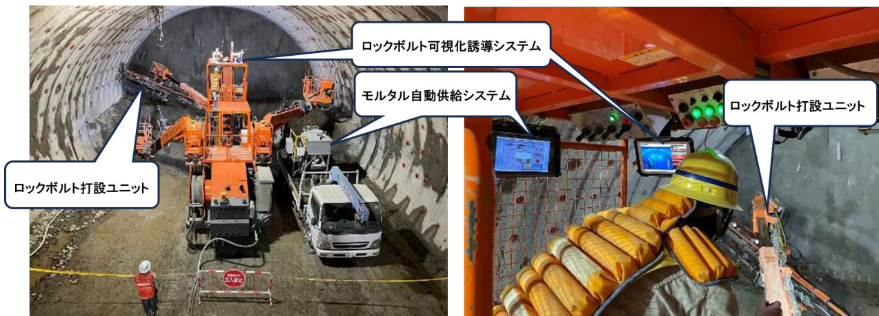
【ロックボルト自動打設システム「離れteロック」 実施状況】
