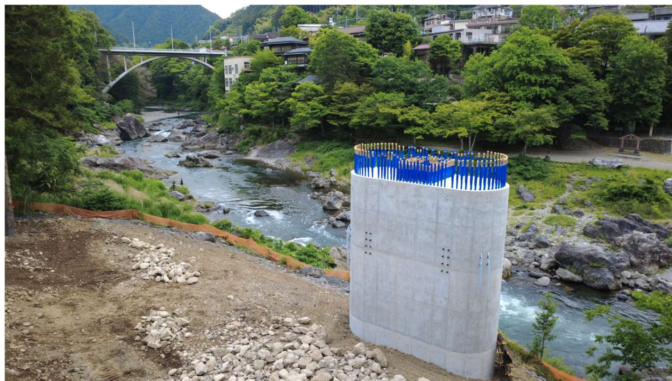
高流動・低炭素型コンクリートを採用した御岳小橋の P1 橋脚
