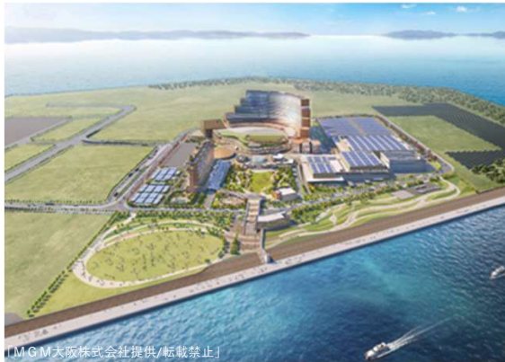
(仮称) 大阪IRプロジェクト ブロックC新築工事
