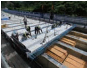
SMC-Slabを適用した蓼野橋作業所
