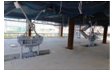
揺動機構部の設置状況
