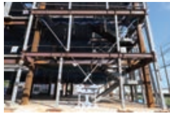
実物件に初適用された揺動制震システム ※制震ダンパー設置前
